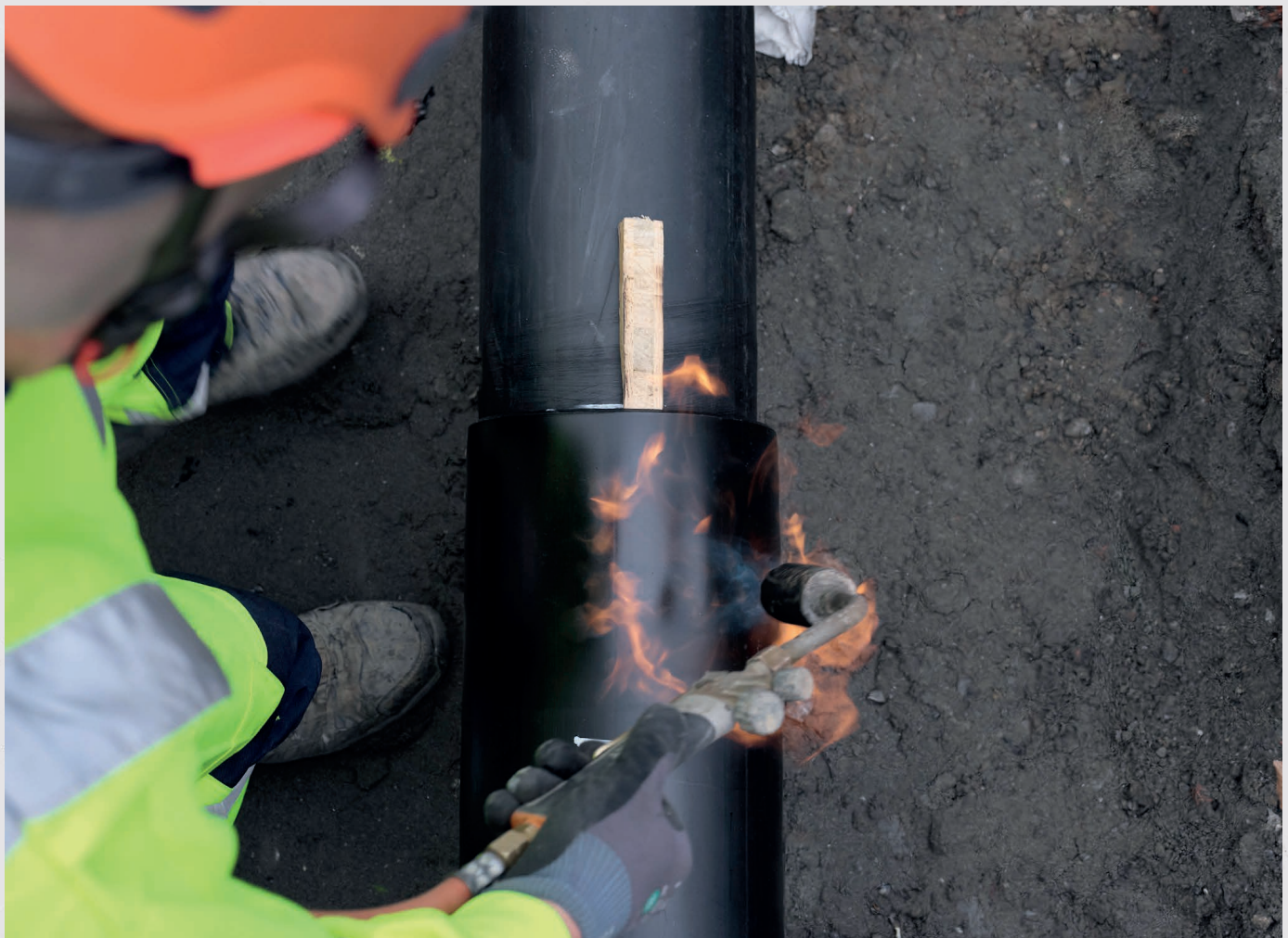
Fernwärmeleitung, Vaduz (Rohrleitungsbau)
