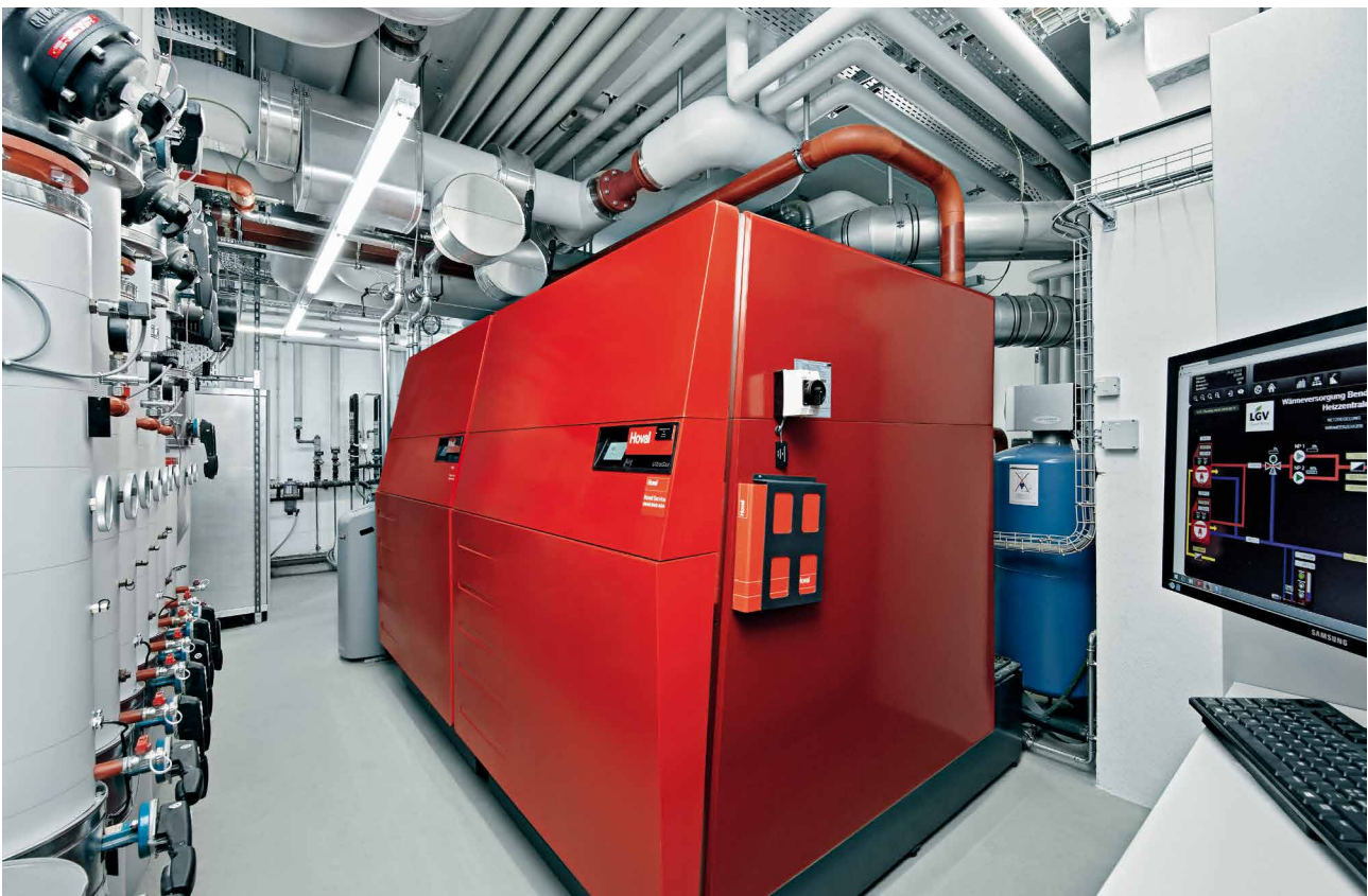
Wärmeversorgung Bondern Industrie (Heizzentrale)
